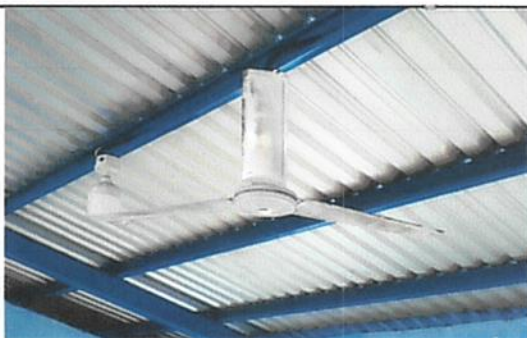
Foto 5: REPARACIÓN DE SISTEMA ELÉCTRICO
