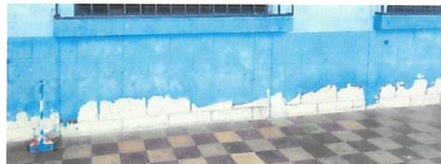
Foto 2: REPARACIÓN DE REPELLO Y CERNIDO DE PAREDES. Reparación de repello y cernido en muro de mampostería con aplicación de acabado uniforme. En paredes interiores y exteriores del establecimiento
