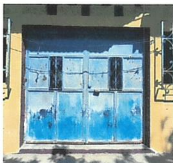
Foto 3: MANTENIMIENTO A PORTONES
