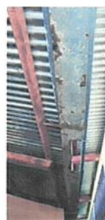
Foto 6: CANALES Y BAJADAS DE AGUA PLUVIAL
